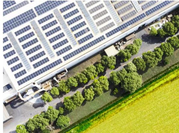
GF Casting Solutions installierte PV-Anlagen mit einer Kapazität von 2,0 MW auf den Dächern ihrer Standorte, darunter das 1,4-MW-System der Eisengießerei in Kunshan (China).
