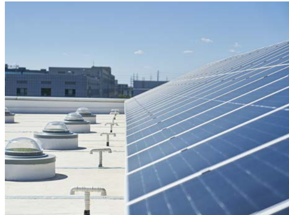
Das Werk Shenyang (China) ist mit Lichtkaminen und lokalen Solarmodulen ausgestattet.
